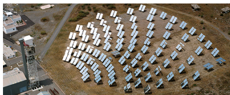
Figura 10. Sistemas de torre con recepción central [29]. Concentra la radiación entre 200-1000 veces. Potencias unitarias de 10 a 200 MW. Temperaturas alrededor de 1300 °C.
