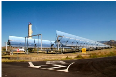
Figura 6. Colectores cilindro parabólicos. [26]. Concentra la radiación entre 30-80 veces. Potencia unitaria de 30 a 80 MW. Temperatura entre 200 y 400 °C.
