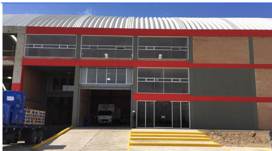
Ilustración 1. Fotografía Bodega Principal MRO; Enel-Codensa. Fuente: Elaboración Propia
