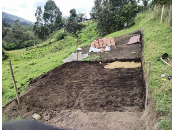
Ilustración 7: Área destinada para la construcción del nuevo corral porcino en la finca objeto de estudio; Elaboración propia (2026)
