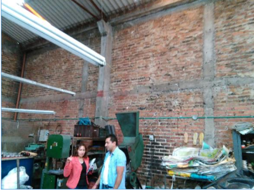
Imagen 2. Bodega costado derecho
