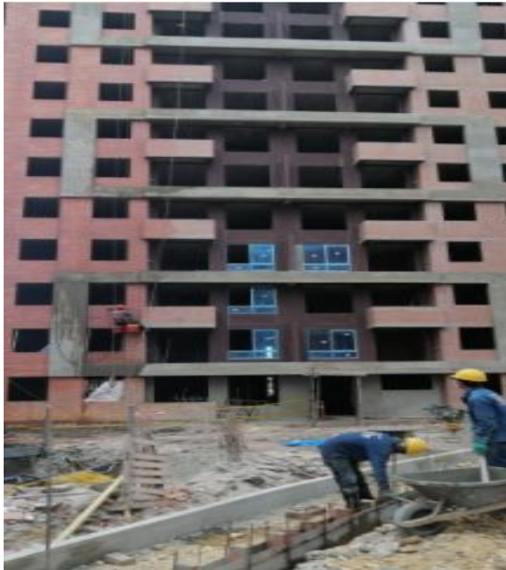
Figura 3 Trabajadores en la construcción
