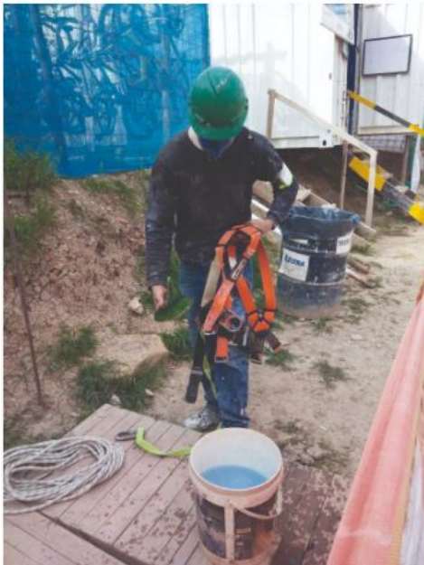
Figura 2 Trabajador en obra
