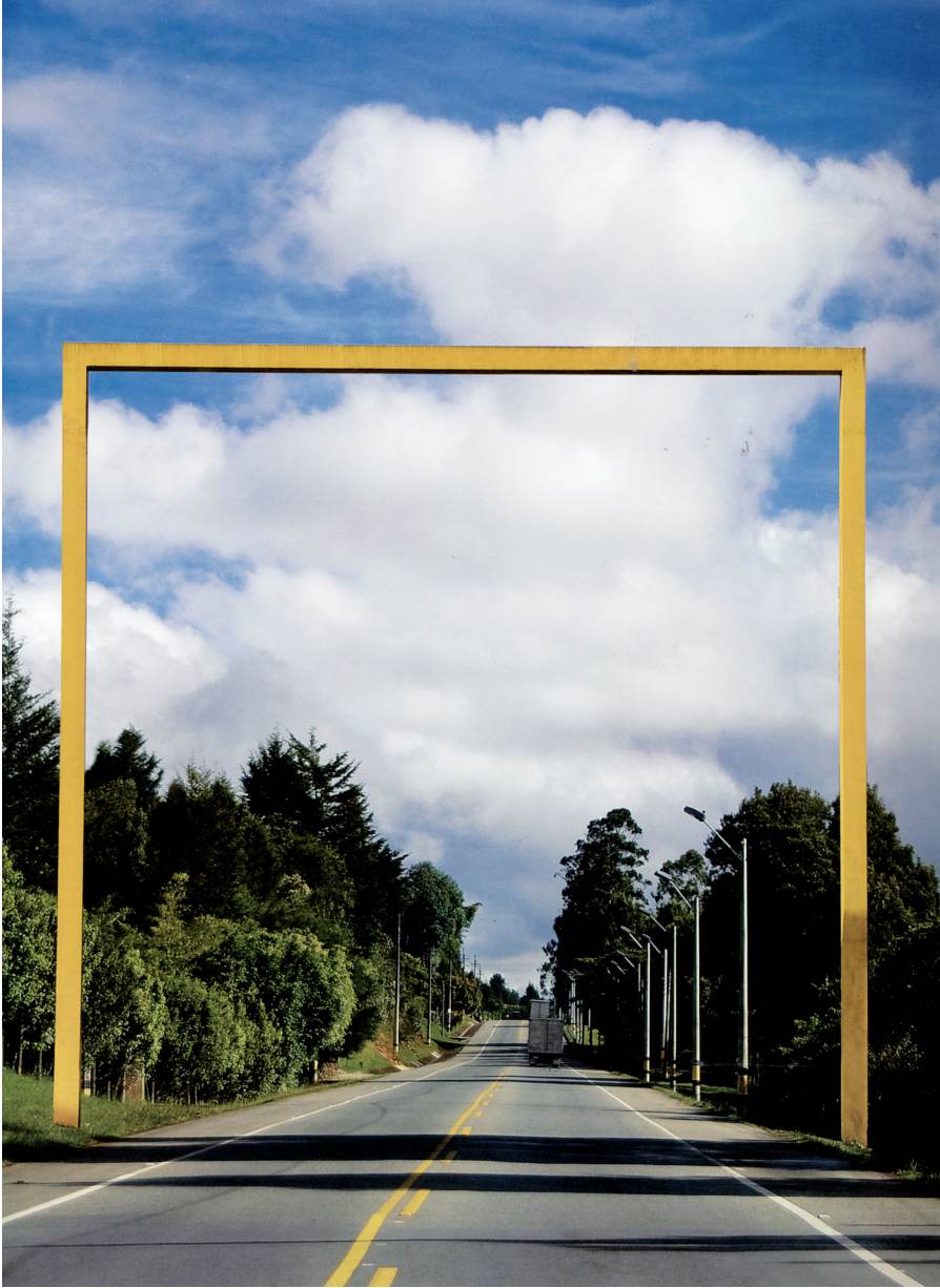
Pórticos Aeropuerto Jose Mario Córdoba, Rionegro, Antioquia
