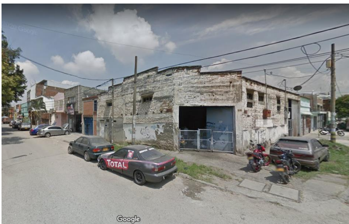
Figura 2. Fachada del Taller de BKPLAST SAS. Fuente www.google.com/maps .
