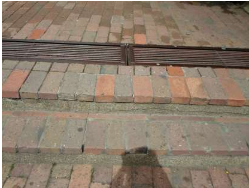
Foto 3: Escalones Bloque B
