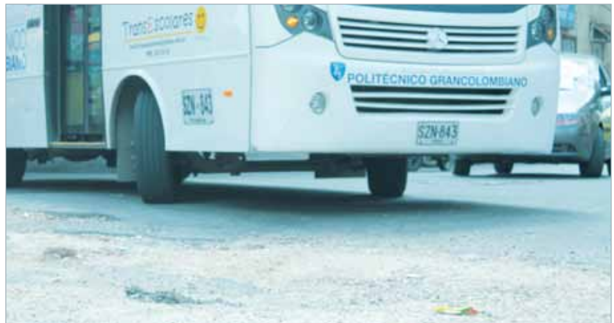
SEGUNDO HUECO 5 METROS ANCHOY 8 METROS LARGO CALLE 61 CON CARRERA 8 A
