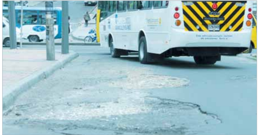
PRIMER HUECO 2 METROS ANCHOY 11 METROS DE LARGO CALLE 61 CON CARRERA 8 A
