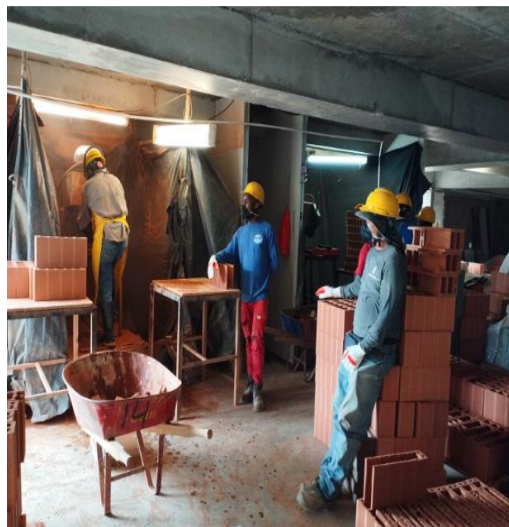
Figura 21. Operador del equipo cortador de ladrillo y ayudantes de mampostería.
