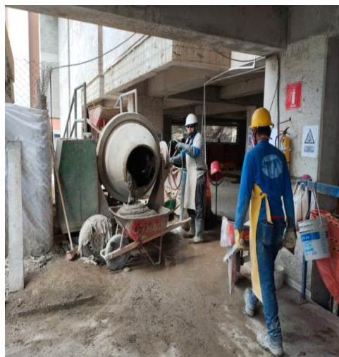
Figura 20. Operador de concretadora y ayudantes de mampostería
