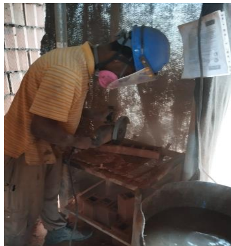
Figura 24. Oficiales y ayudantes cortando ladrillos con equipo pulidora eléctrica.
