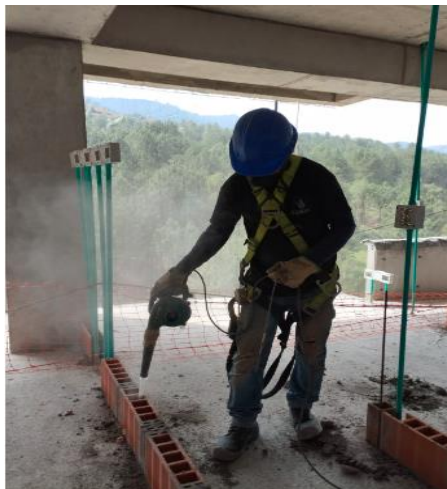
Figura 22. Oficial anclador de dovelas
