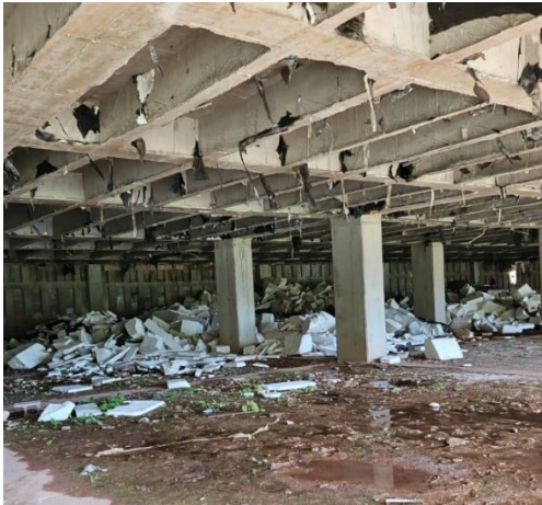
Ilustración 7 Desperdicios de EPS en construcciones
