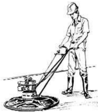
Figura 9 Alisado mecánico utilizando el helicóptero.
