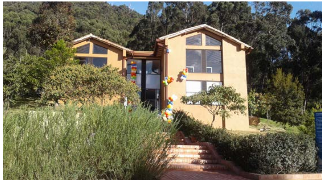
Imagen 7: centro de procesos industriales bloque j
