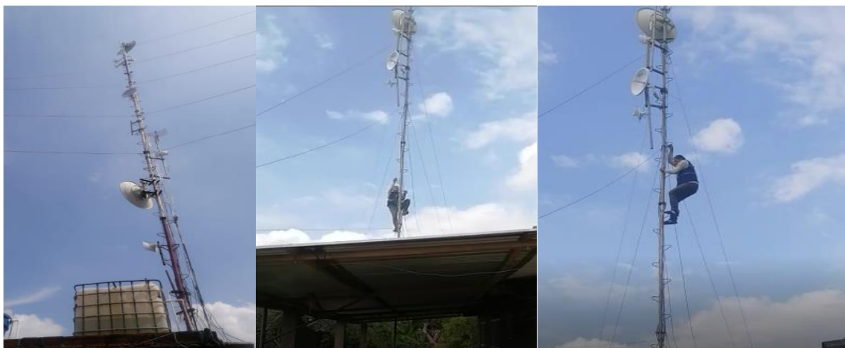
Figura # 3. Ascenso y descenso a nodo para realizar mantenimiento.
