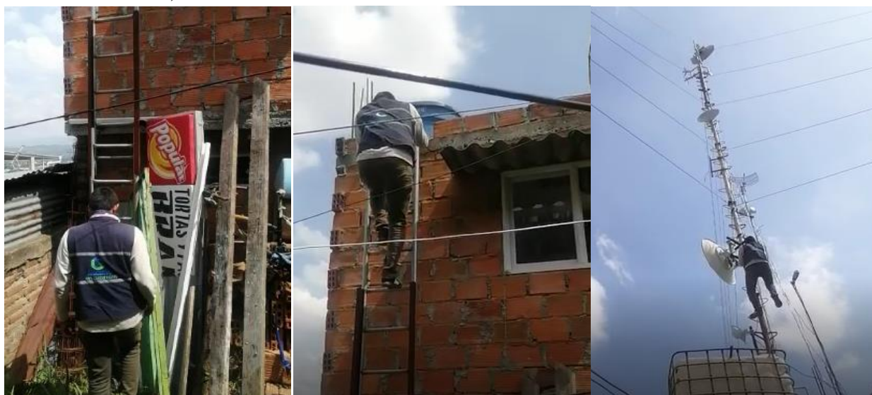
Figura # 4. Ascenso del técnico operativo por escalera fija al Nodo Quilichao (principal) para verificar estado de la antena. Fuente: autoría propia
