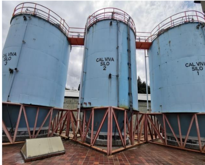
Ilustración 1. Silos de almacenamiento de cal. Fuente: Propia
