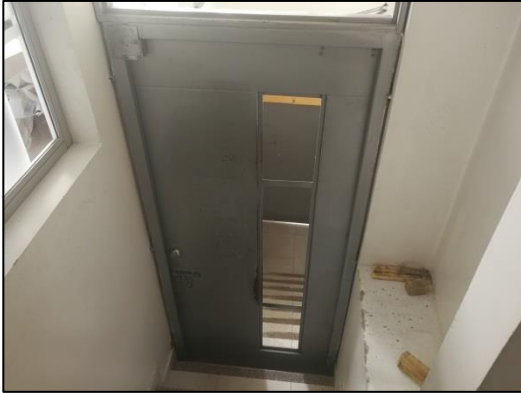
Figura 9 Ingreso entrada principal tipo exclusiva
