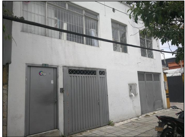
Figura 5 Vista exterior fachada
