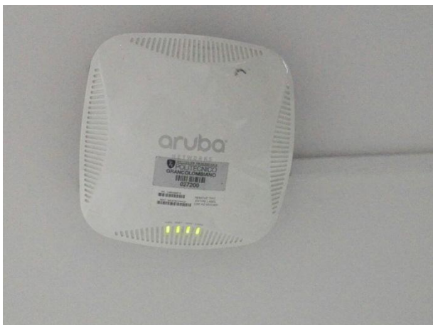
Figura 28 Cuarto piso – Pasillo (García, et al 2018) Institución Universitaria Politécnico Grancolombiano
