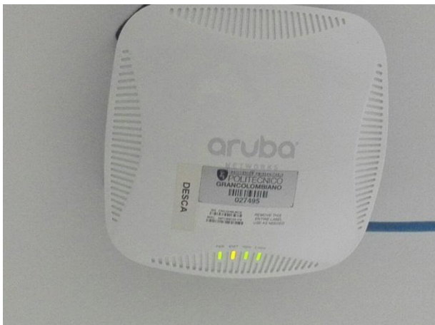
Figura 26 Cuarto Piso – Pasillo (García, et al 2018) Institución Universitaria Politécnico Grancolombiano
