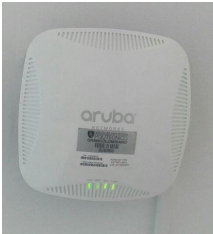
Figura 17 Pasillo - Segundo piso (García, et al 2018) Institución Universitaria Politécnico Grancolombiano
