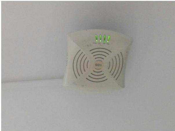
Figura 16 Pasillo - Segundo piso (García, et al 2018) Institución Universitaria Politécnico Grancolombiano
