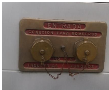
Figura 29. Conexión Para Bomberos 1
