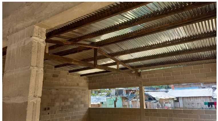
Imagen 4. Construcción de nuevos salones. Fuente: por el autor
