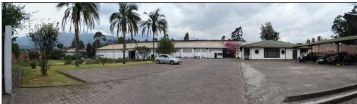
VISTA DE ESTACIONAMIENTOS, ÁREA ADMINISTRATIVA Y NAVE PRINCIPAL
