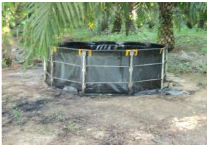
Figura 9. Fast tank en el que se almacena el crudo derramado. Foto propia. El robo de crudo y los atentados terroristas a la infraestructura petrolera afectan la salud de los agricultores y dañan sus cultivos.
