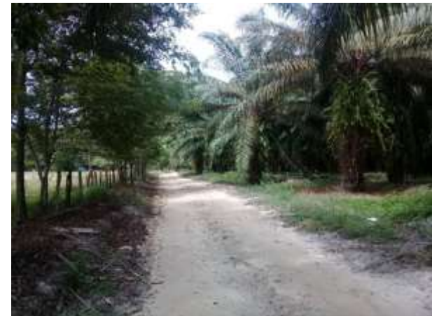
Figura 18. Vía terciaria. Foto propia. Este sector corresponde a la vía terciaria que conecta el casco urbano con la vereda “el serpentino”.
