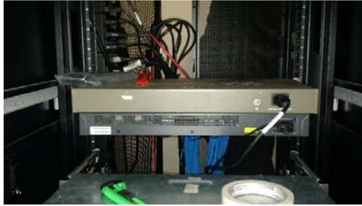
*Ilustración 37 Conexión cables de poder Switch*
