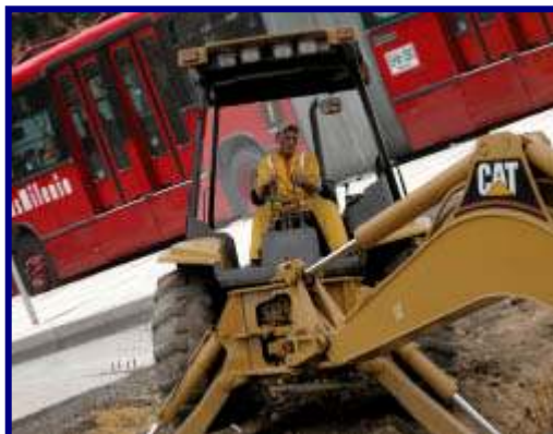
Figura 26. Equipos Cat Rental en obra
