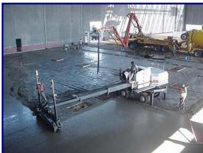
Figura 24. Equipos con tecnología Láser para colocación de concreto
